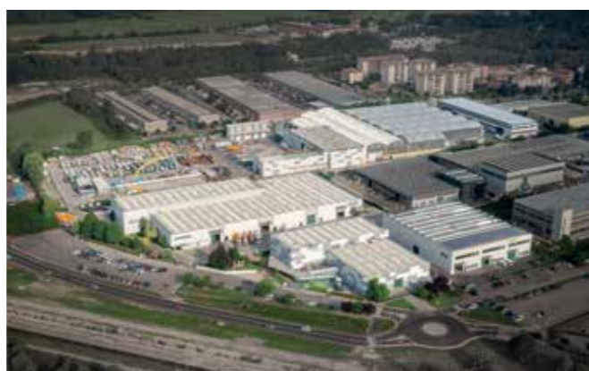
IMPIANTI DI PRODUZIONE
