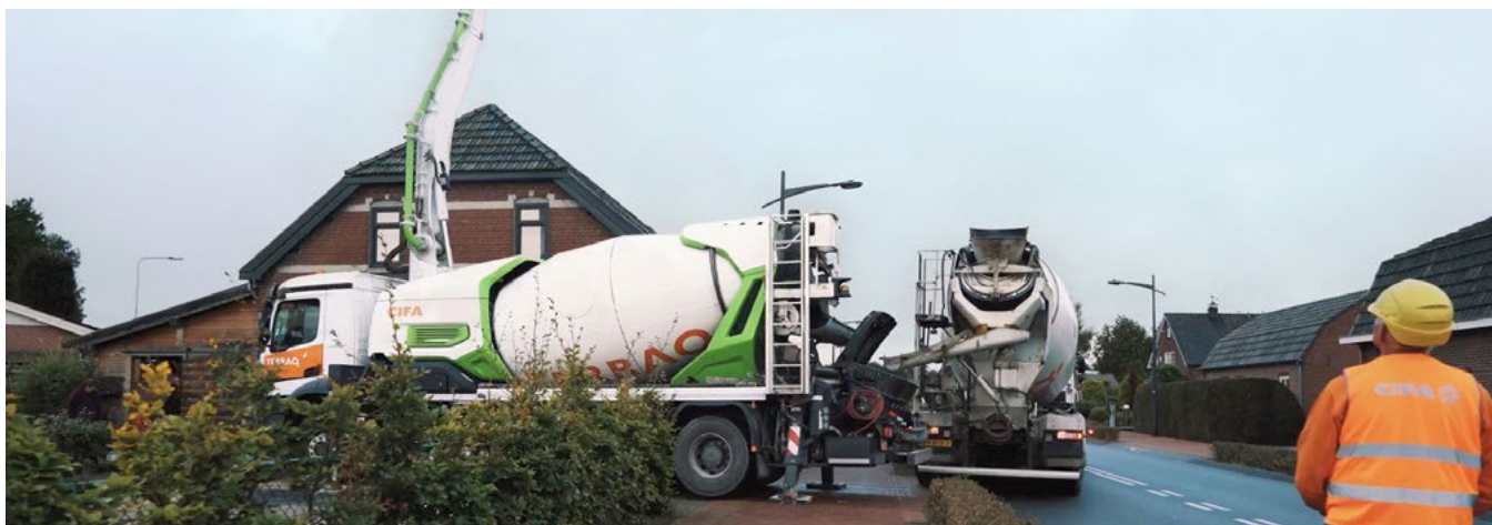
CIFA machines on Nijmegen jobsite | Macchine CIFA nel cantiere di Nimega.
