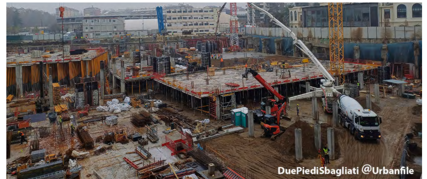
CIFA machines at work at CityLife, Milan I Le macchine CIFA al lavoro nel cantiere di CityWave ("lo Sdraiato") - Picture Courtesy @Urbanfile.
