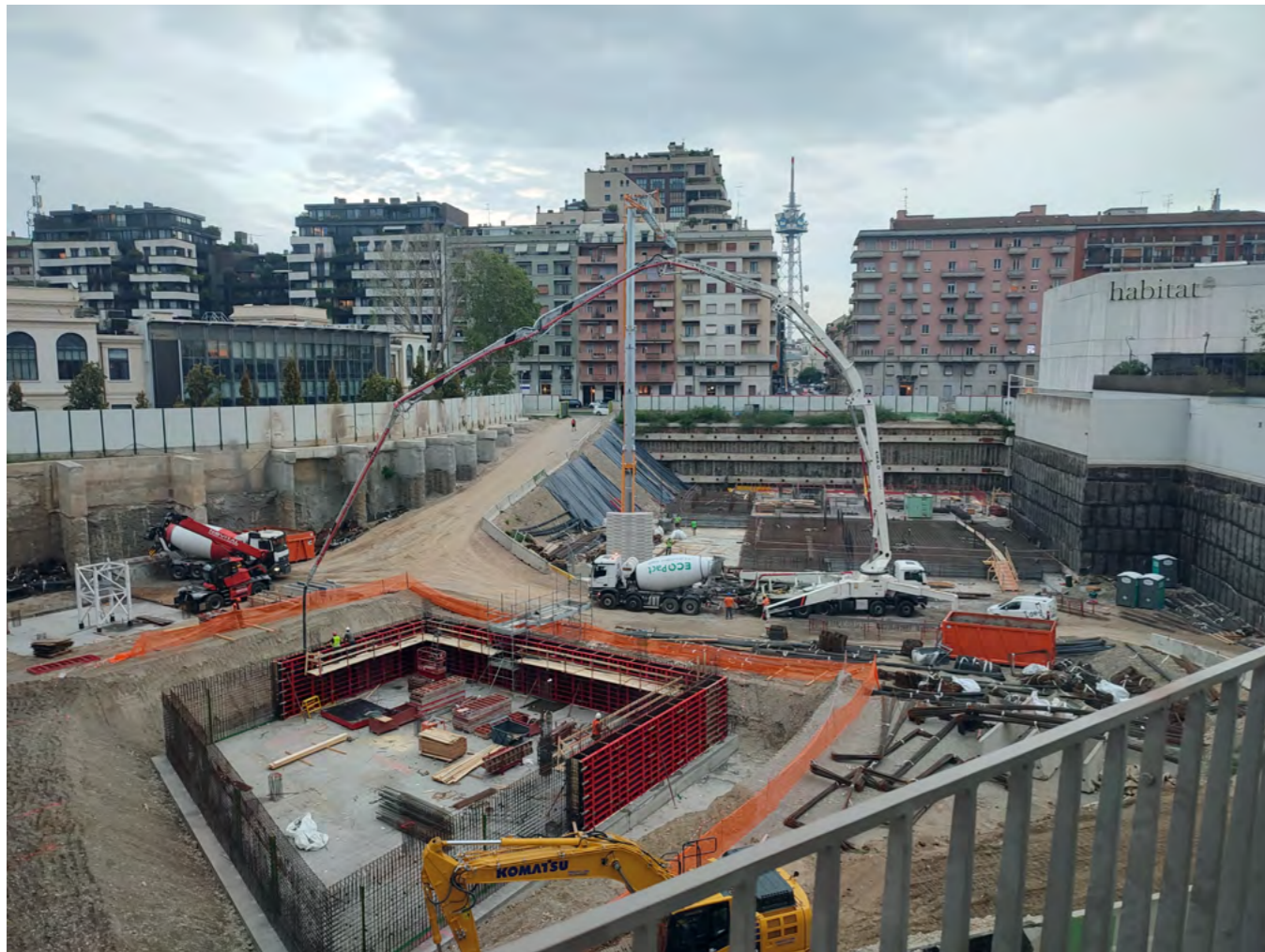
CIFA machines at work at CityLife, Milan I Carbotech K60H nel cantiere di CityWave ("lo Sdraiato") - Picture Courtesy @Urbanfile.
